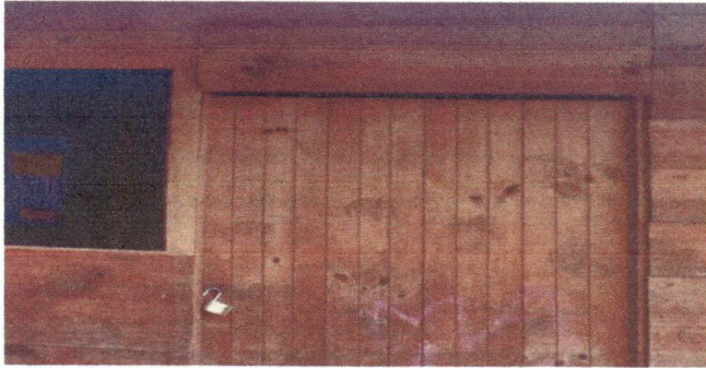
Foto 1: Sustrucción de puerta
