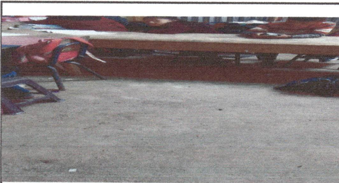
Foto 5: Sustrucción de piso torta de cemesnto interno
