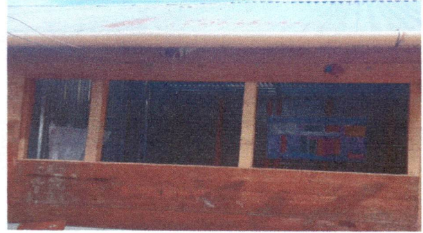
Foto 2: Sustrucción de ventanas de madera por metal mas vidrio
